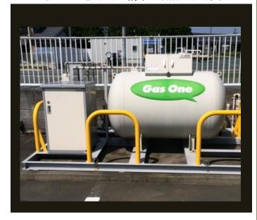
ガス貯槽タンク(バルク設備)で災害時にも LP ガスを利用して煮炊きが出来ます。
